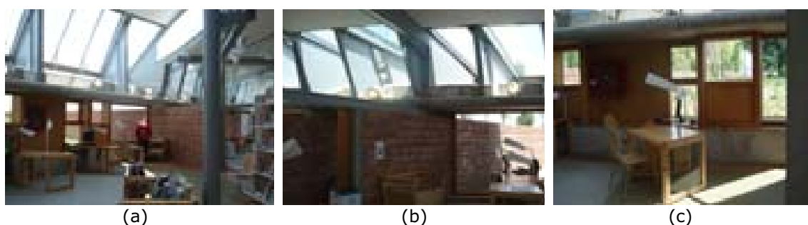
Figura 17. Las vigas metálicas se apoyan en las marquesinas. Figure 17. The metallic beams are supported by the marquees.
