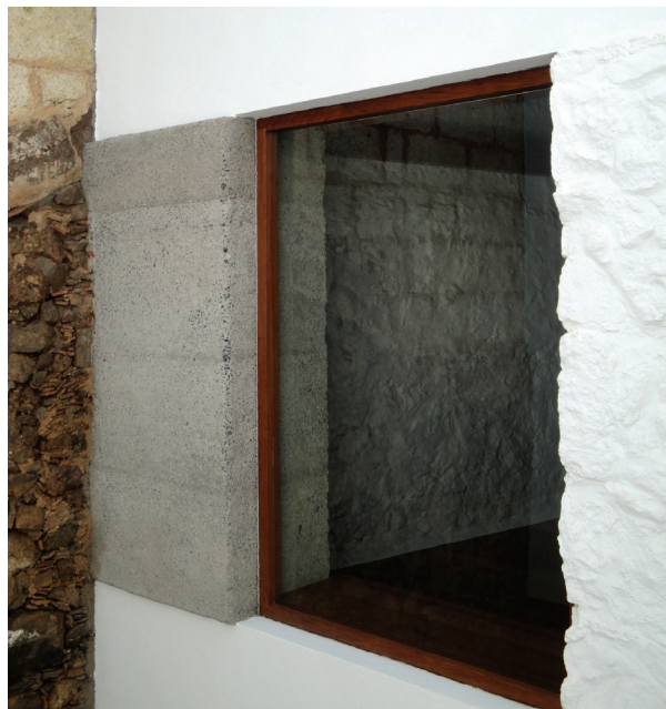
Figura 7. Detalhe do pátio coberto. Fotografia: Efraín Pinto.
