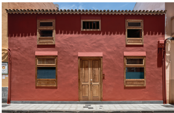
Figura 2. Casa com Duas Faces. Calle Cabrera Pinto. San Cristóbal de La Laguna. Tenerife. Aspecto da casa após a reforma de Beautell. Fotografia: Efraín Pinto.
