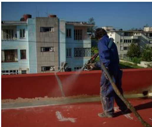
Figura 4. Salida de la mezcla poliisocianato por la boquilla de la pistola. Foto de las autoras.
