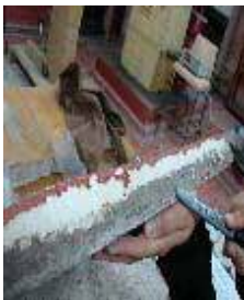
Figura 3. Sustrato de hormigón
