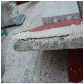
Figura 7. Sustrato de Hormigón
