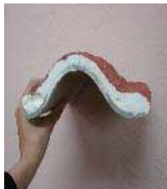
Figura 4. Sustrato de asbesto cemento
