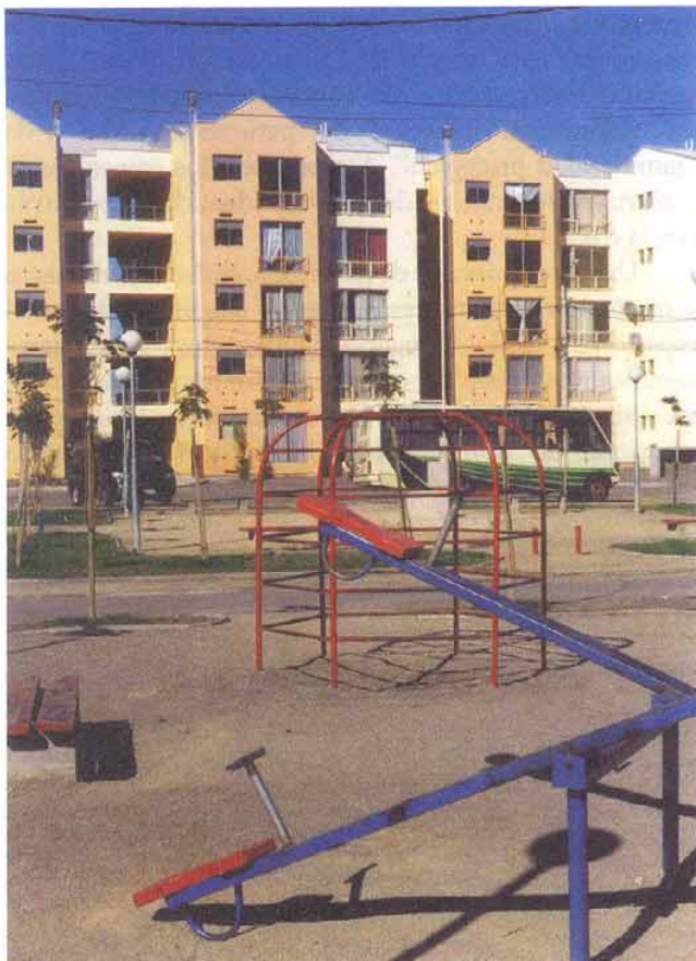
Edificio de Ribera Norte, Concepción.
