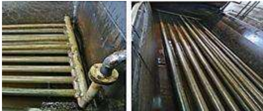
Configuración serpentín doble parrilla e ingreso de vapor lateral
