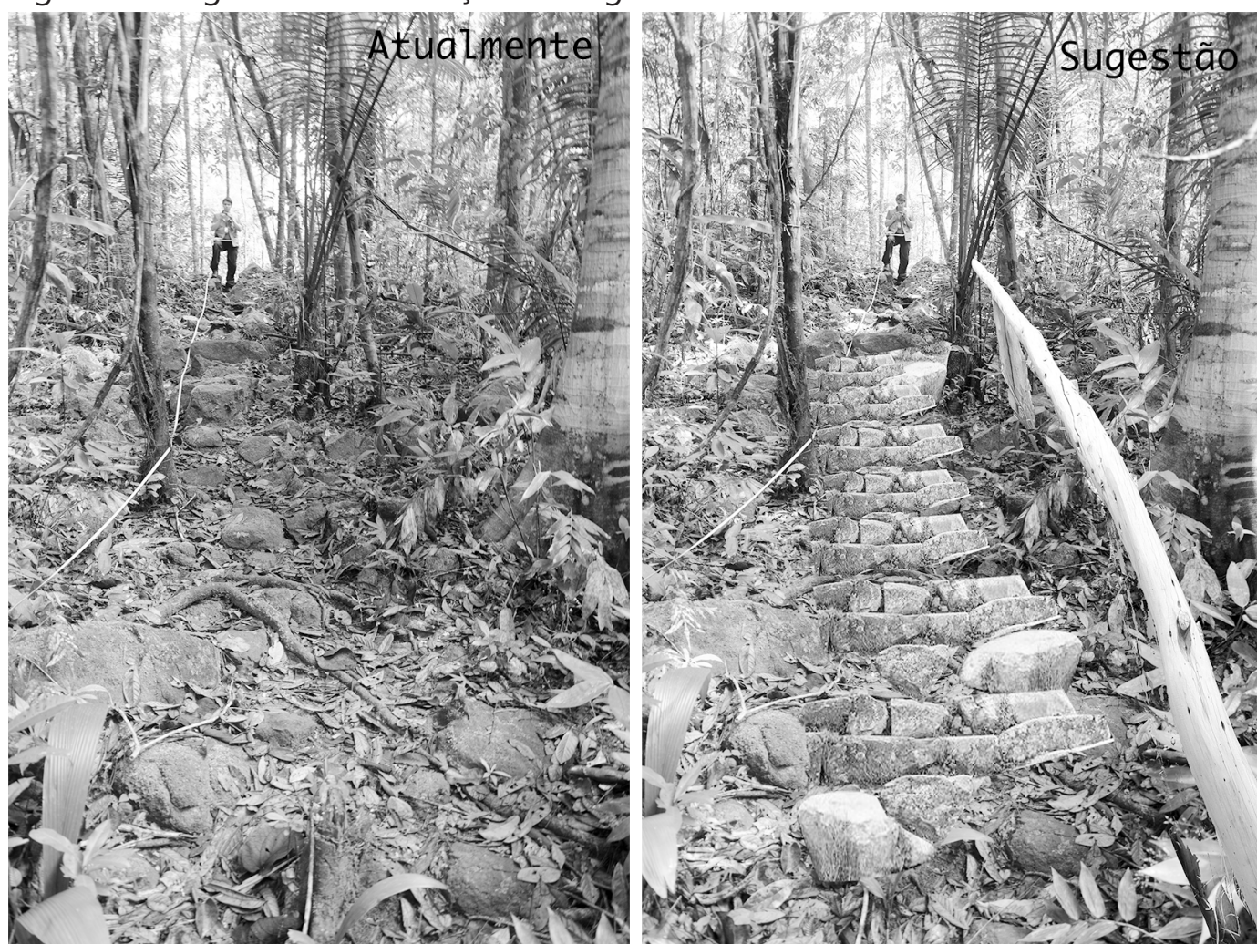
Figura 12: Sugestão de instalação de degraus na trilha.
