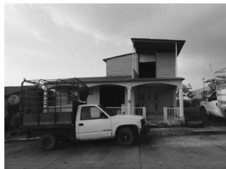
Foto 4. Ampliación con madera.
