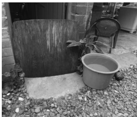
Fotos 9 y 10. Obstaculización del paso del agua de lluvia.
