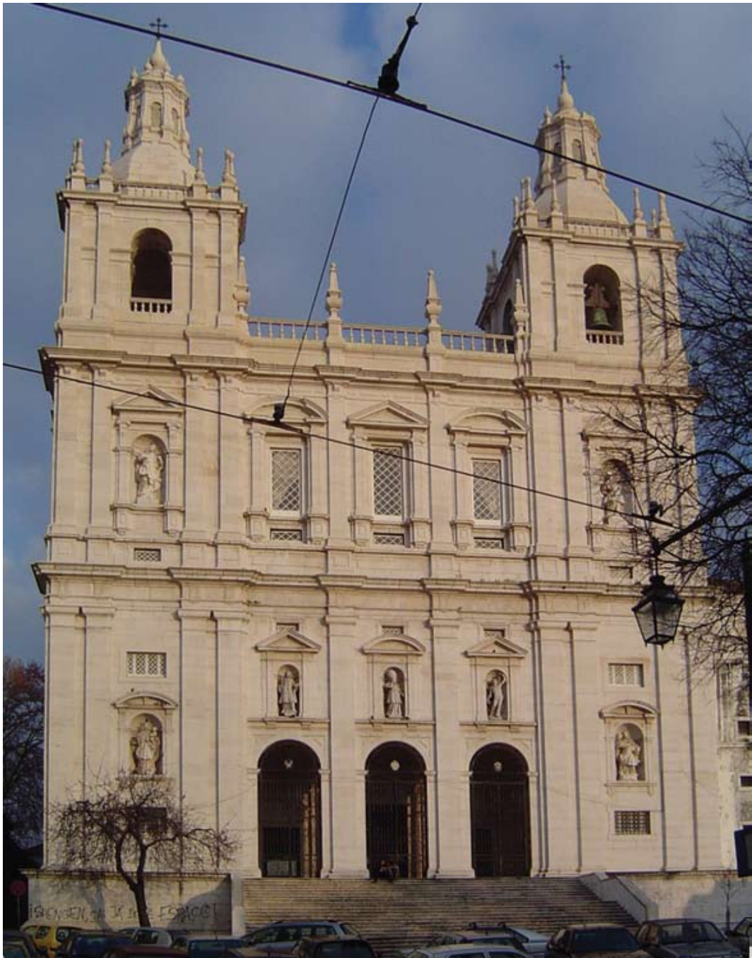
Figura 2 – Após assumir a coroa portuguesa em 1580, Filipe II ordenou a reconstrução da igreja de São Vicente, erigida no local onde foram sepultados os mártires da reconquista de Lisboa aos mouros. O traçado da fachada monumental é de autoria do arquiteto italiano Filippo Terzi. Após a restauração da monarquia portuguesa, a casa de Bragança escolheu o mosteiro como local de sepultamento da família real. Fotografia de Renato Cymbalista, 2006.
