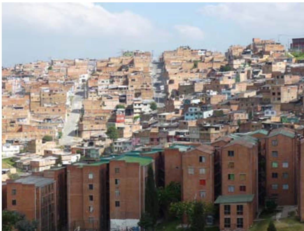
Imagen 4. Edificaciones de vivienda social y barrios autoconstruidos al fondo, Bogotá, sector de Santa Librada dic 2012. Foto: Ricardo Toledo Castellanos.
