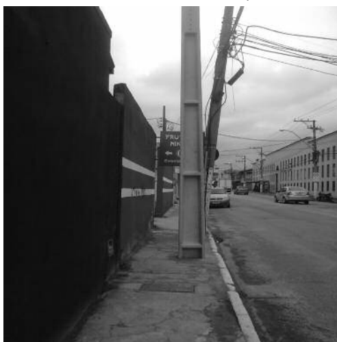
Foto 6 - Poste em local inadequado
