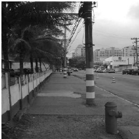
Foto 4 - Piso irregular /obstáculos na calçada
