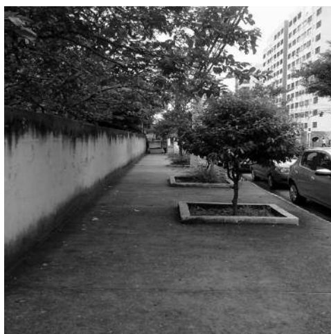
Foto 5 - Tamanho inadequado de canteiro
