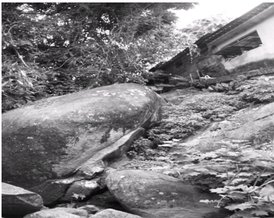
Ocupação na encosta: retirada da vegetação original para construção de moradia; edificação acima da cota altimétrica e declividade permitidas; lançamento de esgoto e lixo.
