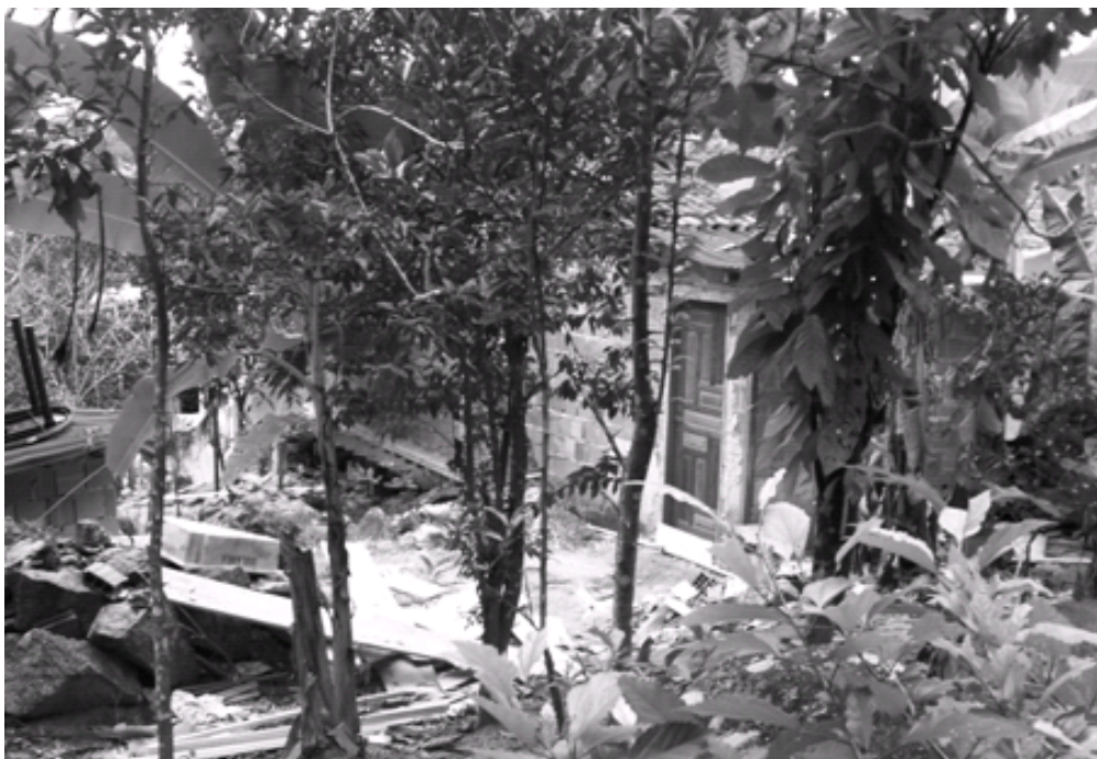
Ocupação às margens do Córrego da Rua do Bicão: retirada da vegetação original para a construção (moradias); entulho e material de construção; comprometimento da floresta marginal por desmatamento.
