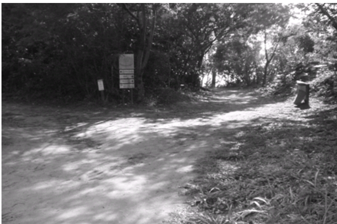
Bifurcação de Trilhas Saco do Céu e Feiticeira: as placassinalizadoras estão ilegíveis e as lixeiras quebradas; alargamentodas trilhas e desmatamento que colabora para o efeito de borda da floresta.
