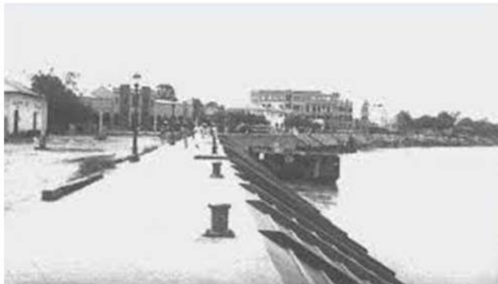
Ilustración 2: Puerto de Montería inaugurado en 1938.
