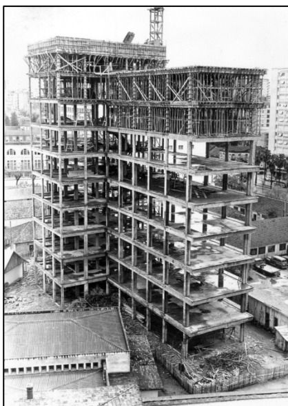
Figura 1 – Prédio da Faculdade de Educação em construção
