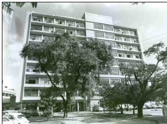
Figura 2 – Prédio da Faculdade de Educação, pronto.
