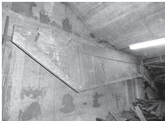
Figura 14. Contrapeso de segmentos de madera, forrado en lata de cinc para evitar el deterioro por el roce con los muros, Manizales, Caldas
