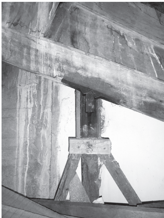
Figura 12. Pivote tipo bisagra: se muestra la bisagra adherida a un trílope y al pie de amigo, Manizales, Caldas
