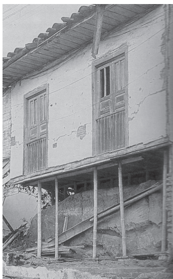
Figura 5. Ganando un piso. Gracias a lo liviano del bahareque se ganó un piso hacia abajo. Fuente: tomado de Robledo Castillo, La ciudad en la colonización antioqueña , 80
