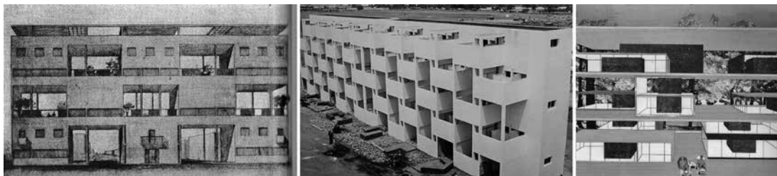
Figura 10. De izquierda a derecha: inmuebles-villa (Le Corbusier, 1925), edificio tipo nido de abeja (Josic-Candilis-Woods, 1952) y Country Estates Waddinxveen The Netherland (MVRDV, 1997)
