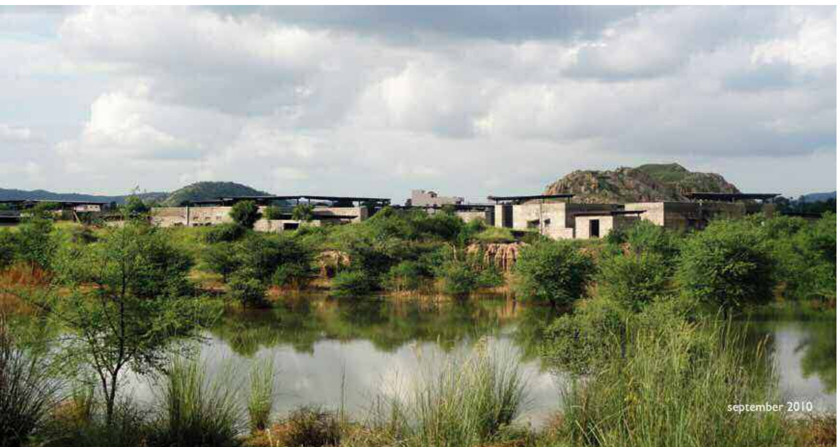
Vista del predio, después de la construcción.
