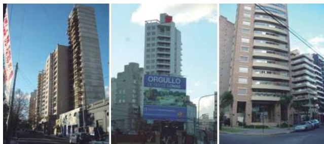
Fig. 8. Edificios en Altura en el Área Central del Municipio de Lomas de Zamora.
