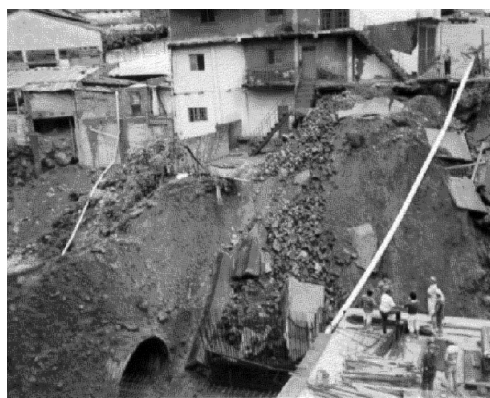
Figura 2. Daños causados por la quebrada La Bermeja a viviendas e infraestructura de la ciudad de San Cristóbal (sector La Guacara).
