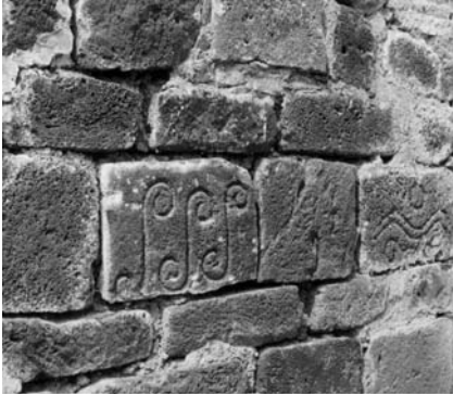
7. Janamus decorados empotrados en la portada de la capilla del hospital, convento de San Francisco, Tzintzuntzan. Foto: Verónica Hernández Díaz, 2000.
