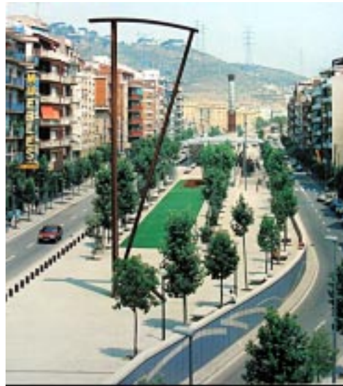
Imágenes 6 y 7. (Ajuntament de Barcelona, 1987.) La reurbanización de la Via Julia constituye un ejemplo paradigmático de cómo el proyecto viario permitió introducir urbanidad en un barrio suburbano de la periferia.
