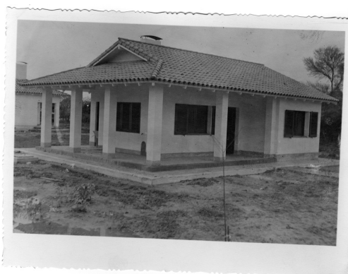
Figura 3. Viviendas en construcción Figura 4. Vivienda con galería perimetral Fuente: Archivo General de la Nación (AGN)
