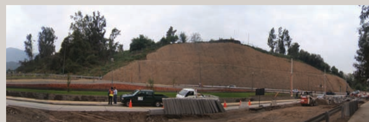
09 Panorámica posterior a la construcción del nudo vial
