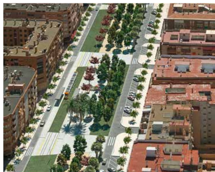
Fig 8 Vista aérea del nuevo trazado del tranvía a su paso por el Bulevar del Pla, Alicante. Fuente: GTP. / Aerial view of the new tramway outline through Boulevard del Pla, Alicante Source: GTP.
