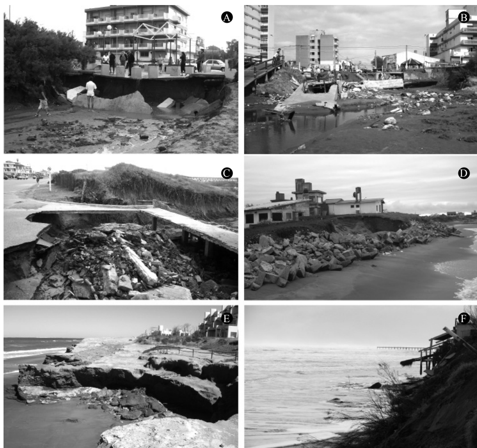
Figura 5. Destrucción de parte del paseo costanero e infraestructura en A) Las Toninas, B) Santa Teresita y C) Mar del Tuyú, luego de un intenso temporal (27-02-08). Remoción en masa y retroceso del acantilado en D) Balneario Mar Chiquita (22-09-09) y E) Bahía de los Vientos (18-03-08), luego de períodos de fuerte oleaje. F) Un intenso temporal con elevada onda de tormenta en Necochea alcanzó el pie de médano en playas extensas con la consecuente destrucción de infraestructura balnearia (22-07-09). Fuente: Archivo personal de Merlotto, Bértola e Isla.
