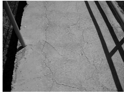
Figura 9. Fisuras en losa
