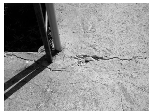
Figura 7. Losa 18 fisura transversal
