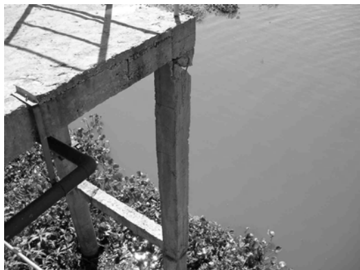
Figura 2. Pilar 25 impactado
