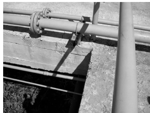
Figura 5. Viga 1k fisura transversal
