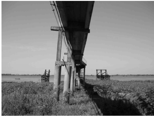
Figura 8. Pilares con desaplomo
