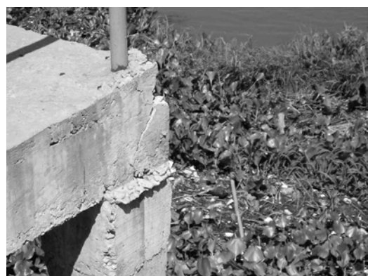
Figura 4. Viga 18 fisurada
