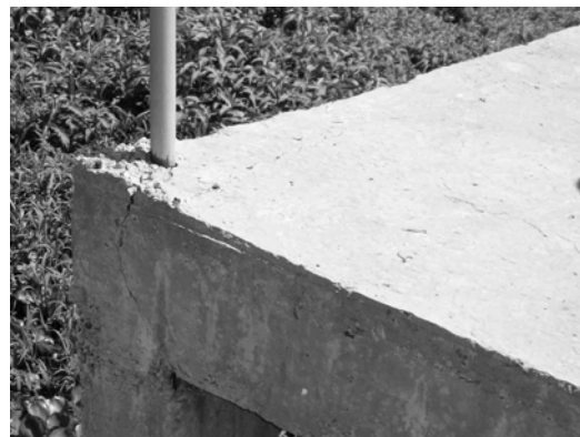
Figura 3. Viga 20 fisurada
