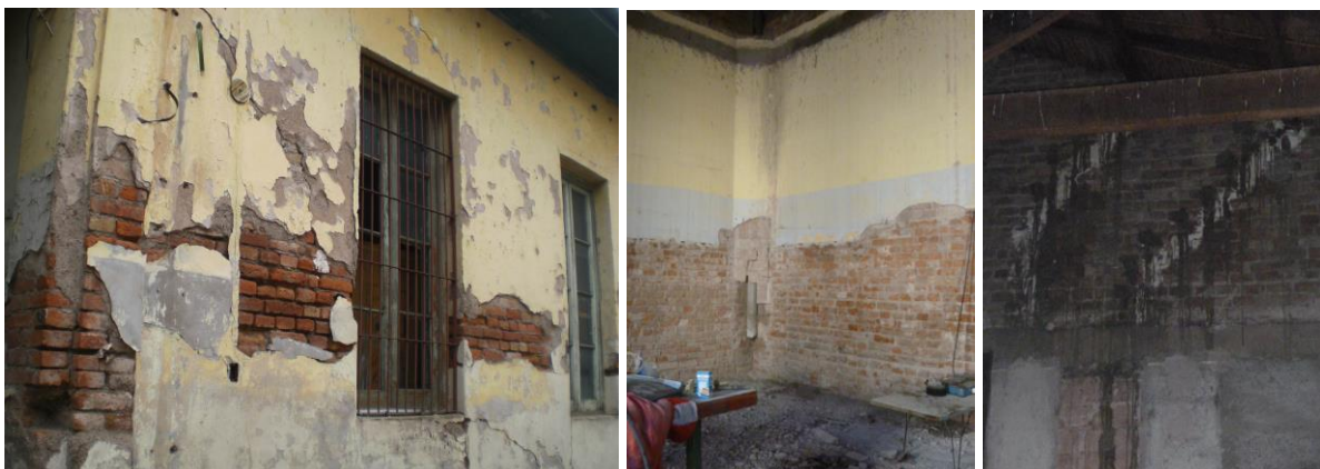
Figura 14. Estado de la mampostería previo a la intervención, estado de la mampostería luego de la recuperación de la cámara de aire y reparación de la mampostería con inyecciones y cosido.
