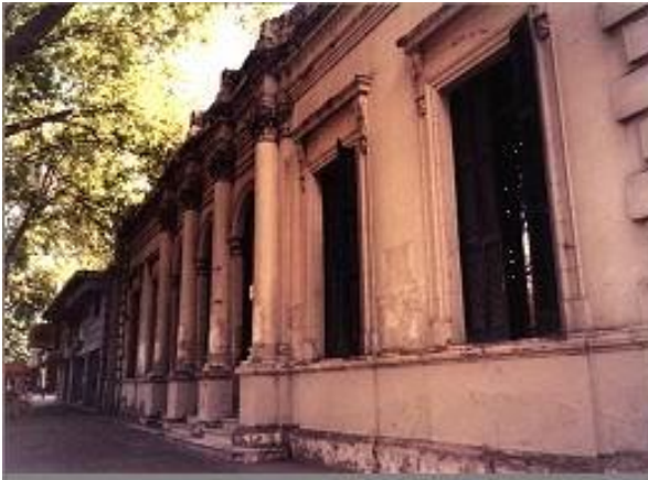
Figura 1. Aspecto de la fachada (año 2000)
