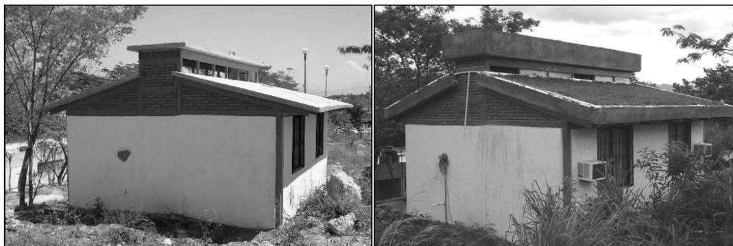
**Figura 13.** Sistema de techo Domotej, antes y después de complementar el techo verde, construida en terrenos de la Facultad de Arquitectura de la UNACH.
