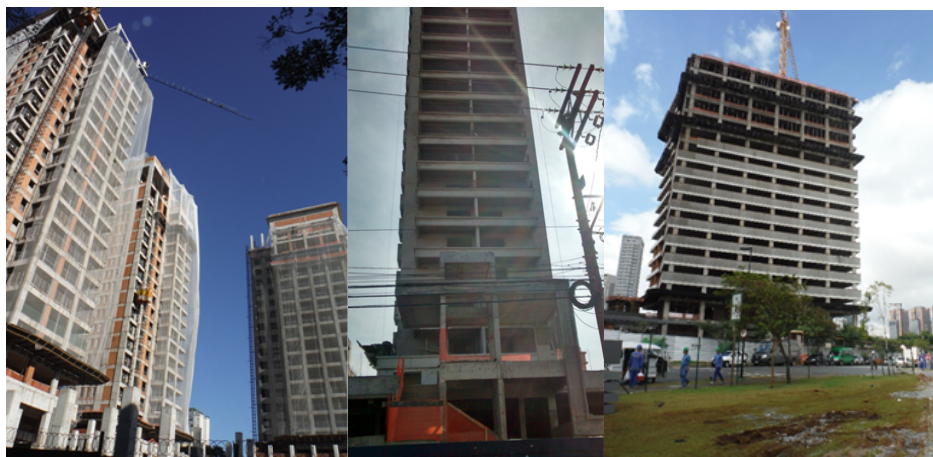
Figura 1. Canteiros das obras 1, 2 e 3 respectivamente. Fonte: Dados da Pesquisa
