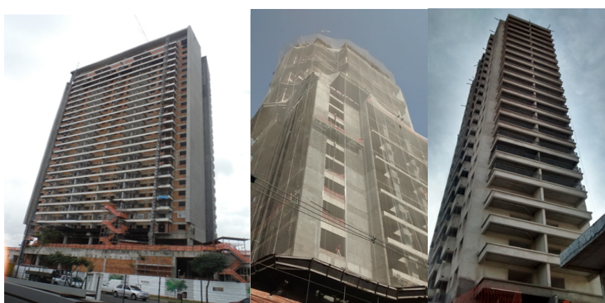
Figura 2. Canteiros das obras 4, 5 e 6 respectivamente. Fonte: Dados da Pesquisa
