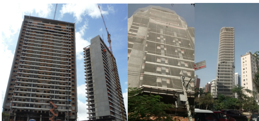
Figura 3. Canteiros das obras 7, 8 e 9 respectivamente. Fonte: Dados da Pesquisa
