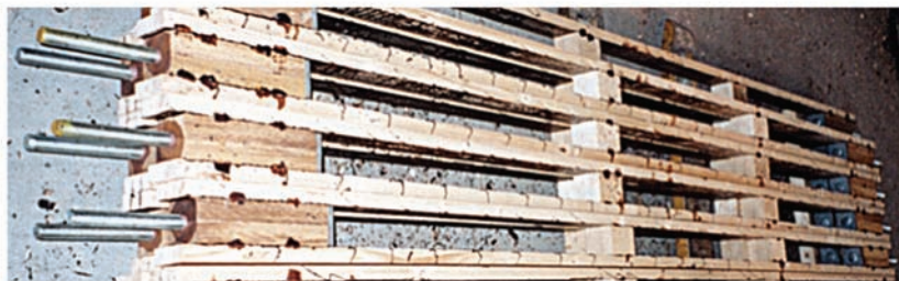
Figura 9. Ejecución de las barras huecas de 3465 mm de longitud.
