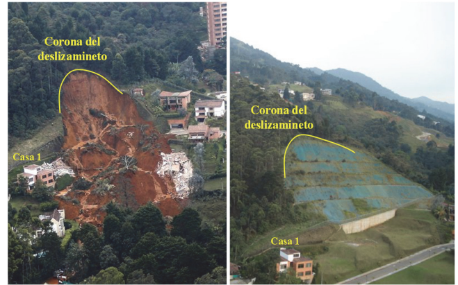
Figura 2. Situación global antes y después de ejecutar las obras de estabilización.
