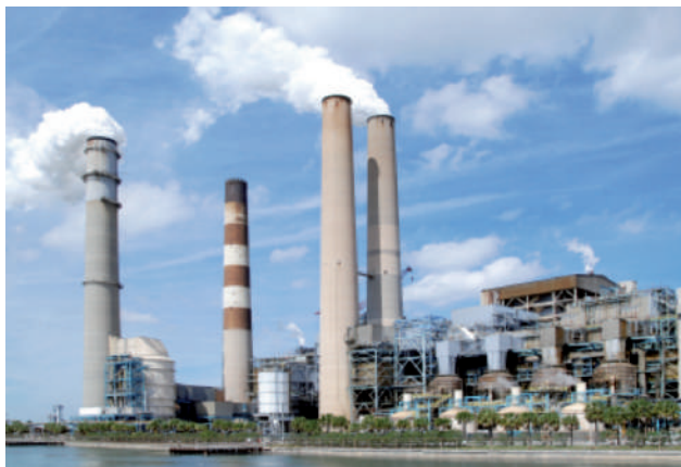
Figura 24: Las usinas que queman carbón para producir vapor que mueve una turbina conectada a un generador producen un alto porcentaje de la energía que consumen muchas naciones (Imagen del dominio público).
