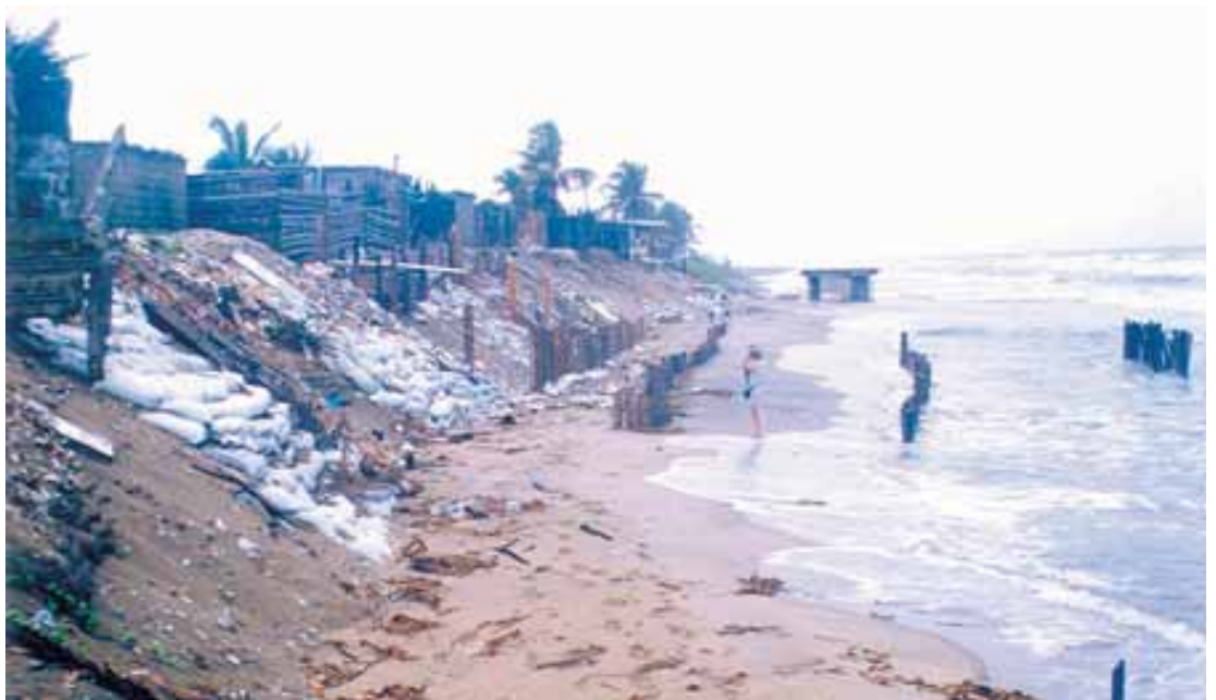
Figura 3. Retroceso de la costa en la localidad de Sánchez Magallanes, estado de Tabasco (septiembre de 2004). Obsérvense las casas derribadas y ocupadas por el mar, y las defensas (frentes de palizadas y de sacos de arena) improvisadas por los habitantes para atenuar los efectos del oleaje.
