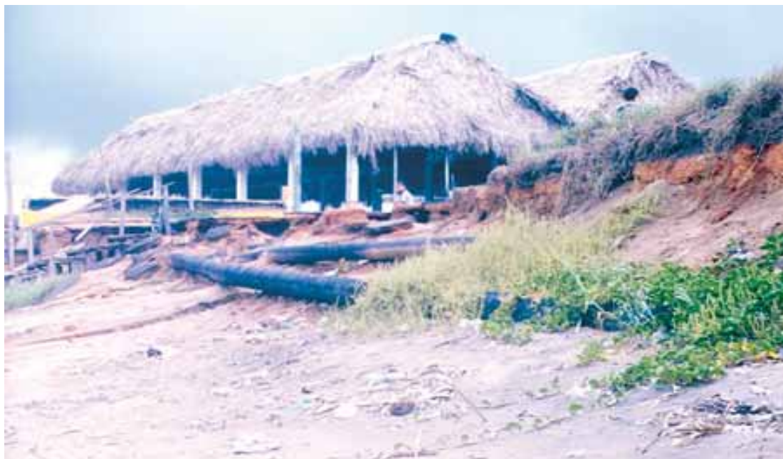
Figura 4. Deterioro de los oleoductos de PEMEX, localizados a lo largo de la costa, que han sido exhumados por la morfodinámica litoral en la porción occidental del poblado de Sánchez Magallanes, estado de Tabasco (septiembre de 2004).
