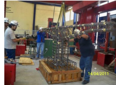
b) Montado previo al colado
