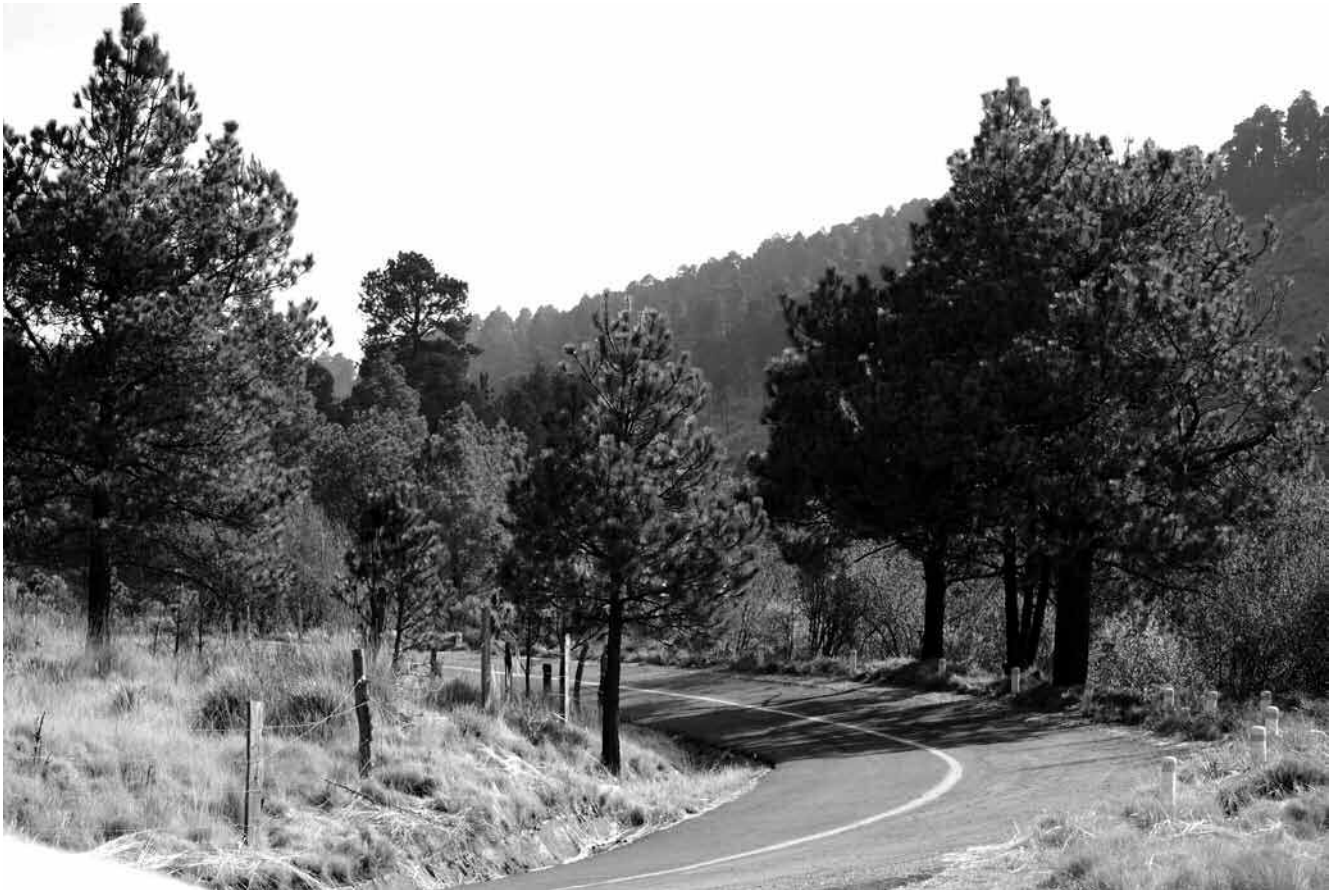
Leonardo Atilano Ponce (2011). Carretera Amecameca-Paso de Cortés.
