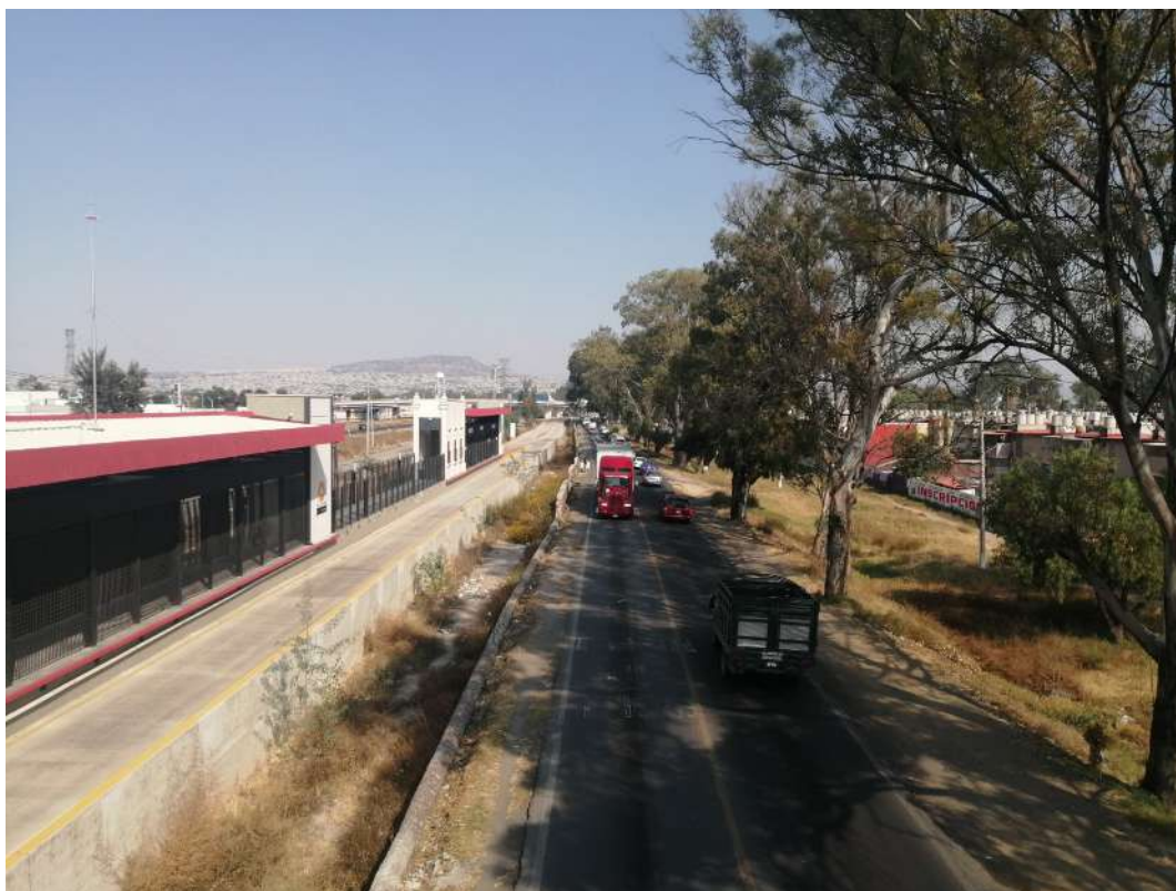
Imagen 6. A la orilla de la nueva estación
