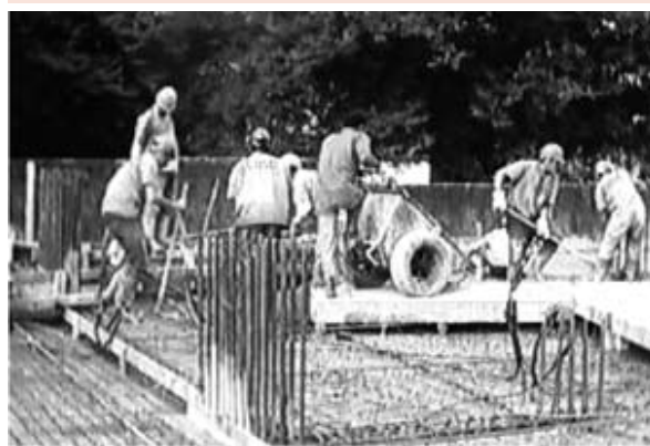
Figura 3: Detalhe da moldagem do pavimento, visualizando-se as jericas sobre os caminhos de madeira utilizados para avanço da concretagem.
