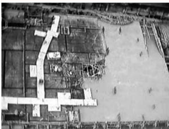
Figura 4: Vista superior da moldagem de um pavimento, visualizando-se parte do pavimento concretado e disposição dos caminhos para início da moldagem da outra parte.
