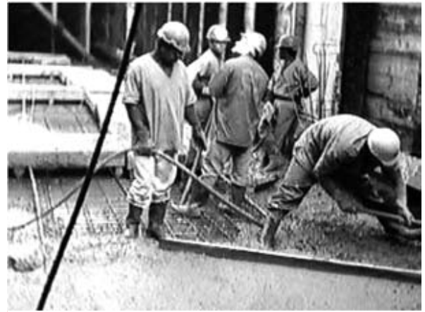
Figura 6: Moldagem do piso, em detalhe, o sarrafeamento da superfície da laje.
