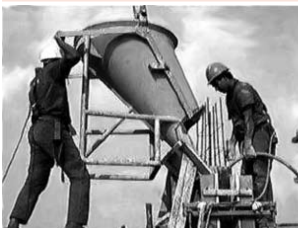
Figura 5: Detalhe de dois operários responsáveis pela moldagem e adensamento de pilar isolado sobre o andaime.
