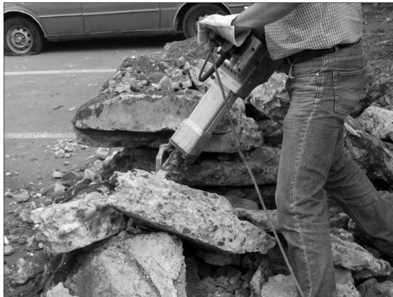
Figura 1. Demolición con martillo neumático
