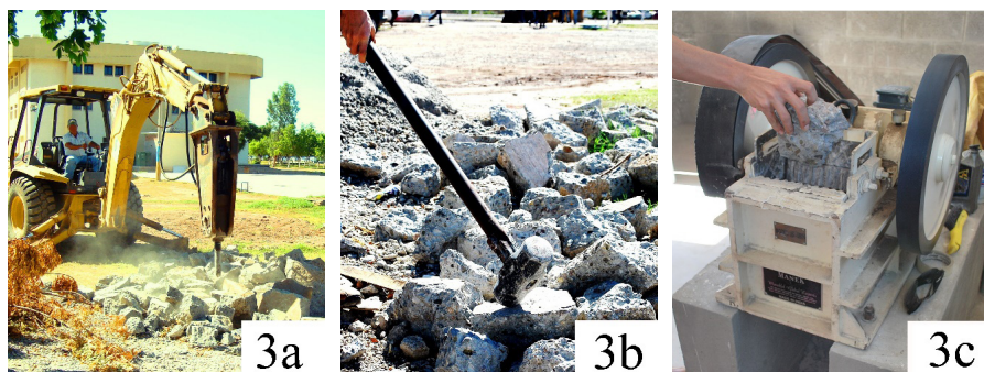
Figura 3. Proceso de trituración del hormigón de pavimento.
