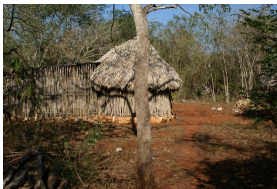
Fotografía 2. Vivienda de huano y bajareque en Pambijib, Tahdziu, Yucatán. (Pablo Quiroz Cantú)
